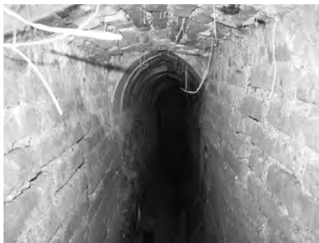
Il tunnel sotterraneo.
