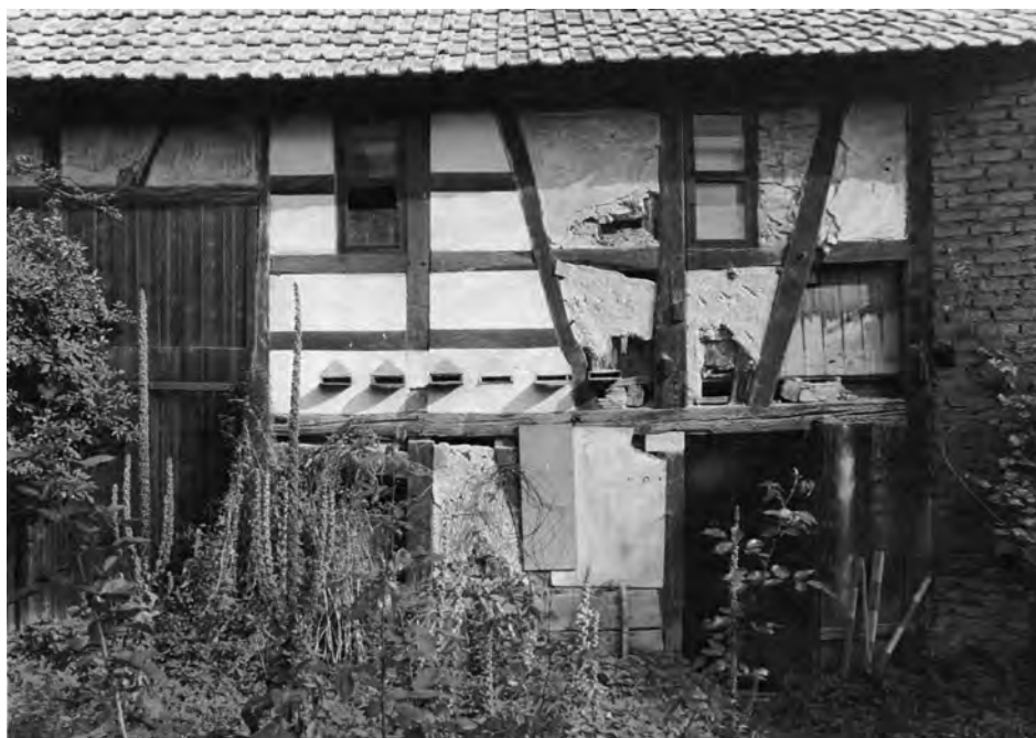
Caratteristica casa/apiario (Alpi centrali): le arnie vengono ispezionate dalle aperture posteriori.
