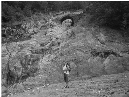
Il ponte e la frana.
