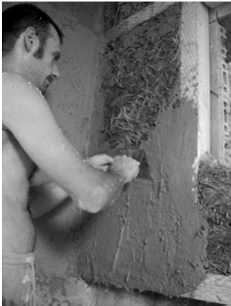
Intonaco di terra cruda su muro di terra e paglia.
