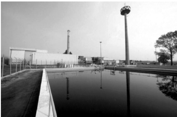
Deposito Avogadro: un bagno in piscina?
