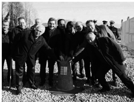
La posa della prima pietra dei cantieri: l’euforia del profitto ora sbiadisce nelle pozze d’arsenico.
