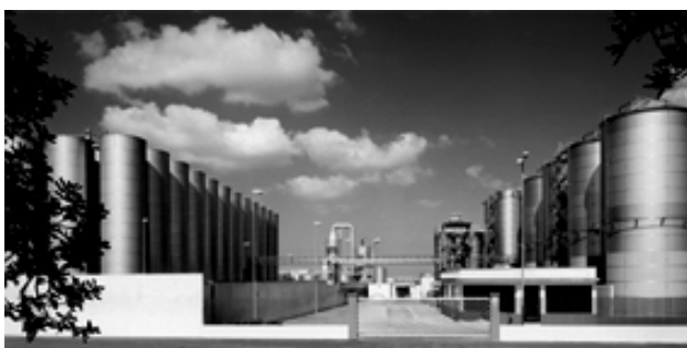
Ital Bi Oil: megaimpianto per la produzione di biocarburanti costruito nel mezzo di un antichissimo uliveto nei pressi di Monopoli (Puglia).
